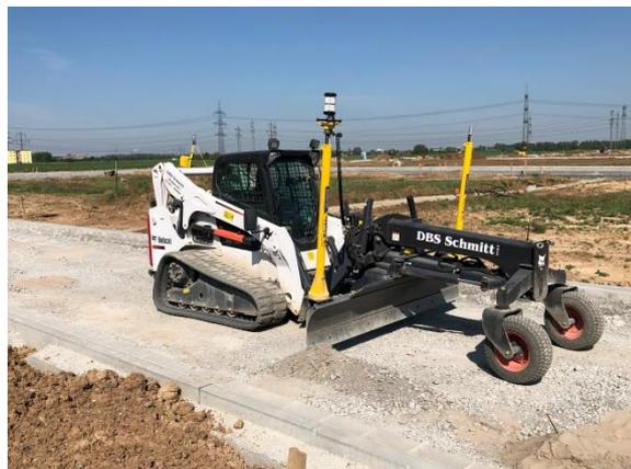
**Bobcat Grader** mit Laser- und UTS Steuerung
