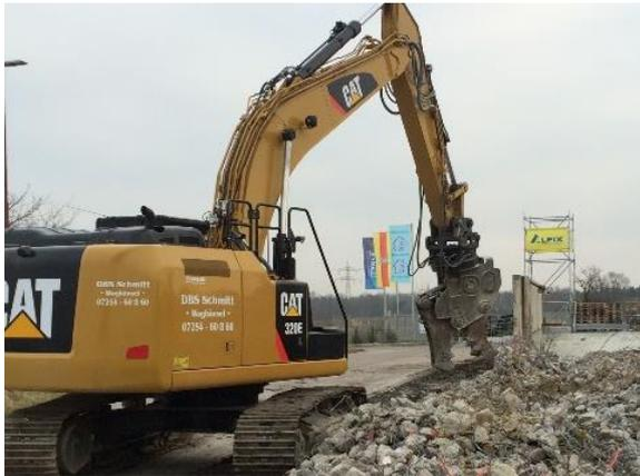
Kettenbagger mit **Pulverisierer**
